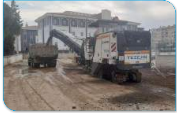
Atıfbey Mahallesi 11/3 Sokak Asfalt Yenileme Çalışması
