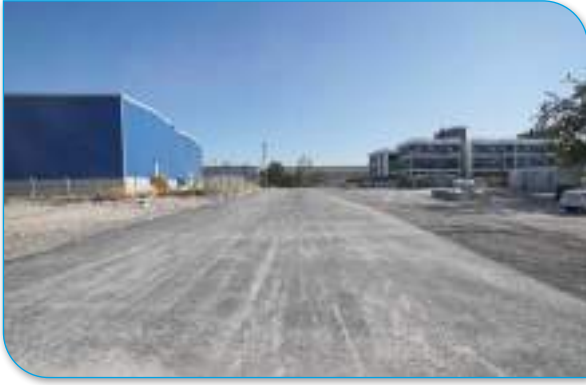
Fatih Mahallesi; 1179 Sokak Asfalt Yenileme Çalışması
