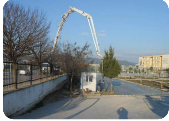
Sarınc Şehit Egemen Yıldız Ortaokulu Bahçesi Saba Betonu Atılması
