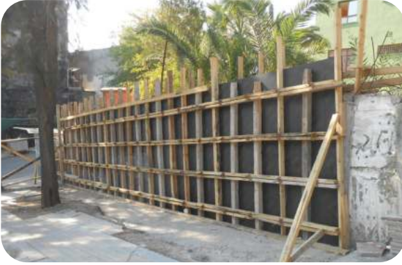
Aktepe Mah. Altan Aydın Cad. Üzeri Park Alanı İstinat Duvarı Yapılması
