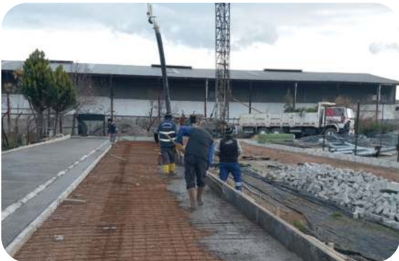
Park Bahçeler Şantiyesi Sera Alanı Yapılması
