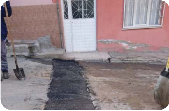
Gaziemir Geneli Asfalt Yama Çalışmaları
