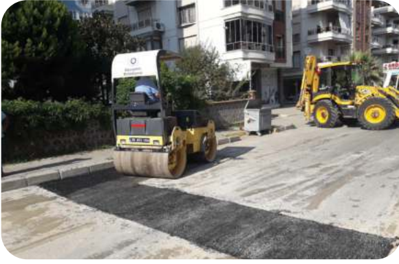
Gaziemir Geneli Asfalt Yama Çalışmaları
