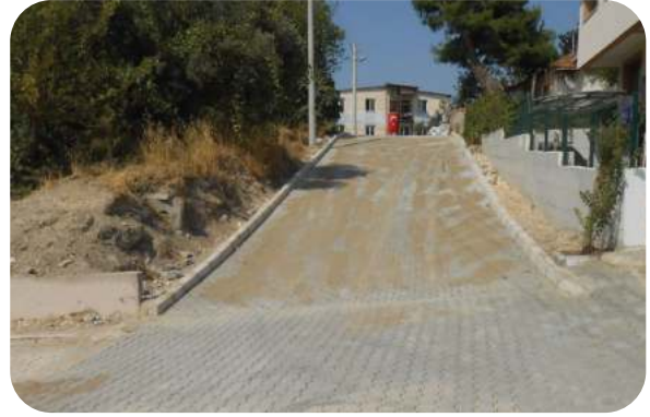
Büyük Menderes Cad. Havaalanı Tarafı Yol Genişletme Taş Döşeme ve İstinat Duvarı Yapılması
