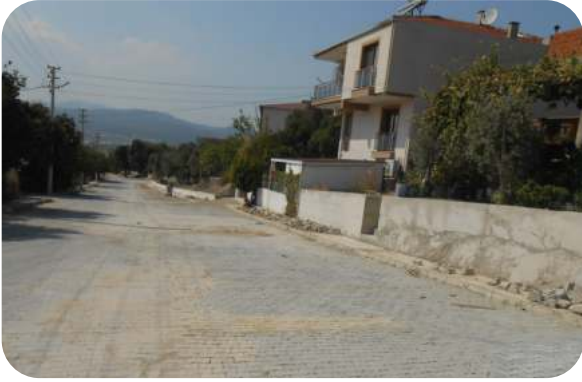
Büyük Menderes Cad. Havaalanı Tarafı Yol Genişletme Taş Döşeme ve İstinat Duvarı Yapılması
