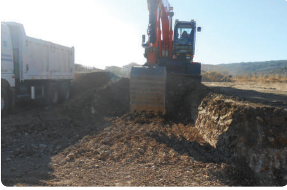
Irmak Mahallesi 700 Sk. Yol Açma İşi
