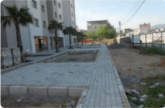
Binbaşı Reşat Bey Mah. Kaldırım Yapım İşi
