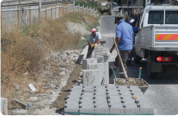
Beyazevler Mahallesi 351 Sk. Yol Parke Tamir İşi
