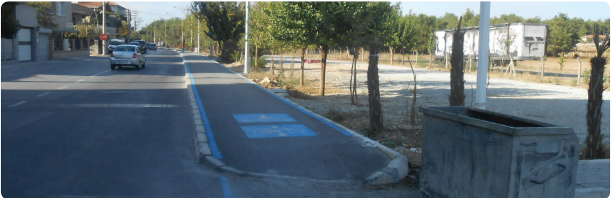
Sarnıç Bisiklet Yolu Yapım İşi
