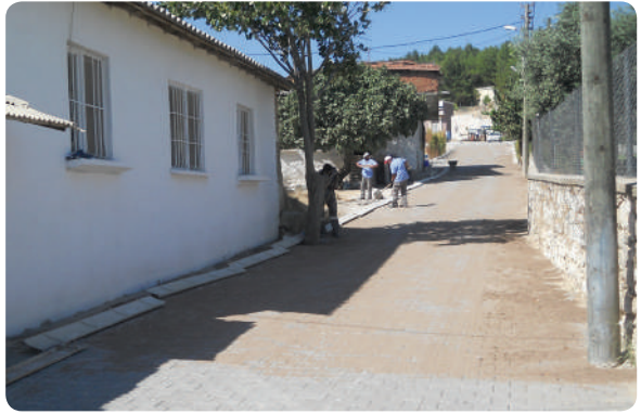
Irmak Mahallesi 39/1 Sk Bordür Kaldırım ve Yol Kilit Taş Döşeme İşi
