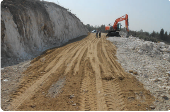
Beyazevler Mahallesi 557 Sk. Yol Açım İşi
