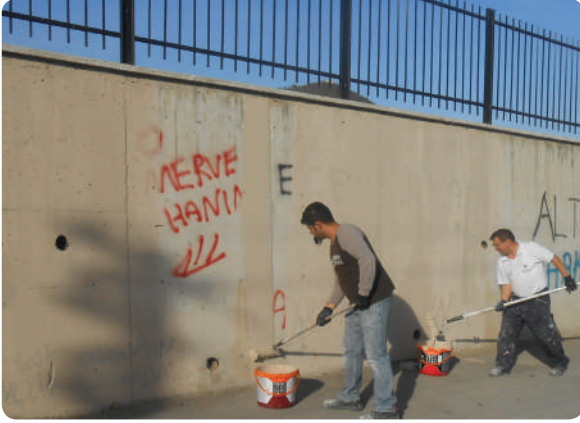
Gazi Umurbey İ.Ö.O. Bahçe Duvarının Boyanması
