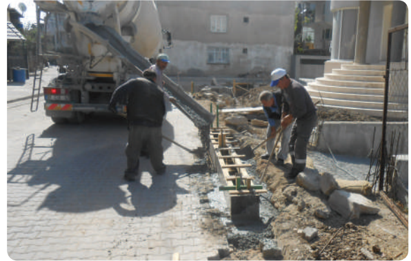
Sarnıç 1176 Sk. Yağmur Suyu Hattı ve Izgara Çalışması
