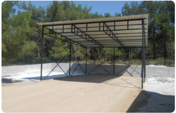
Sarnıç Yangın Müdahale Birimi Otopark Alanı Yapımı
