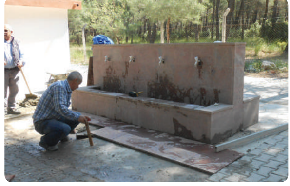
Sarnıç Piknik Alanı Çeşme Yapımı
