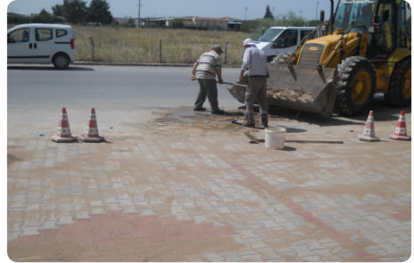
Sarıuç Ege Cad. Kaldırım ve Oto Park Yapım İşİ
