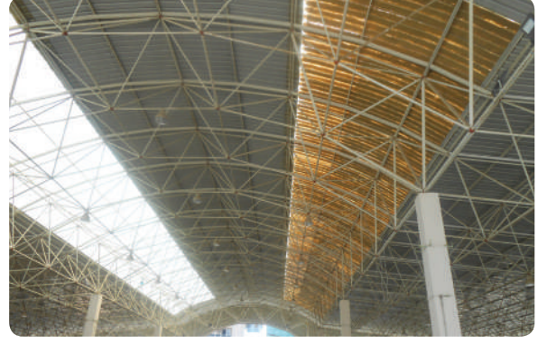
Gazimir Merkez Pazar Yeri Çatı Boyama İşİ
