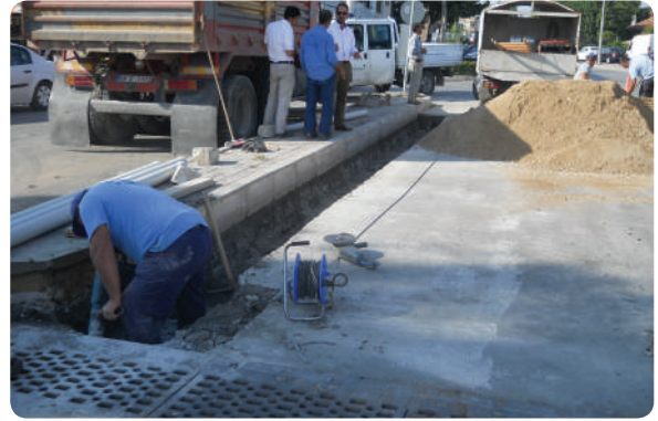
9 Eylül Mahallesi Pazar Yeri Kanal Yapım İşi
