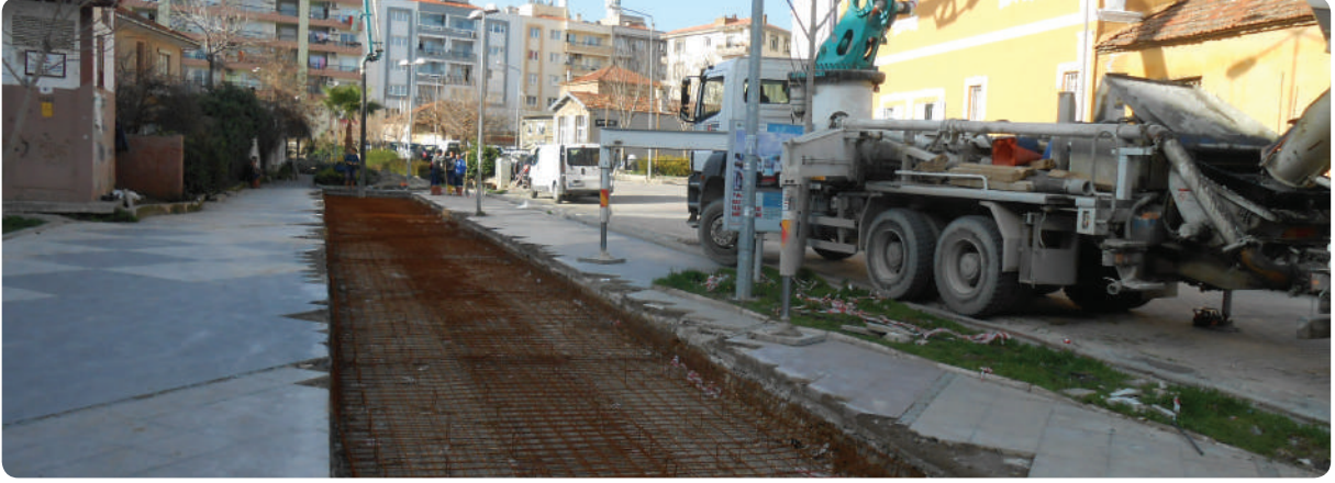
Sevgi Yolu 1 Etap Lokomotif Yer Çalışması
