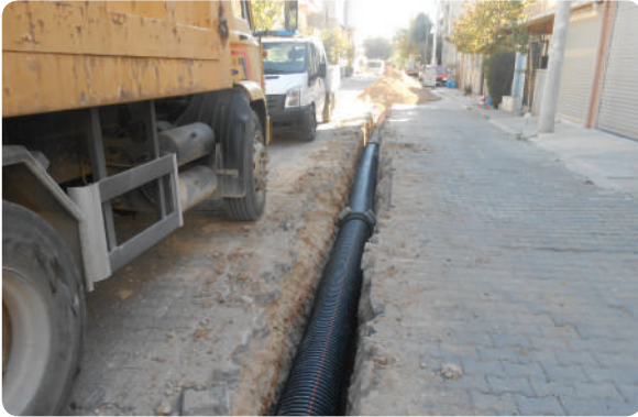
Sarnıç 1138 Sk. Yağmur Suyu Altyapı Ve Izgara Çalışması
