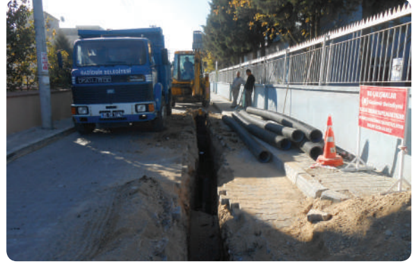
Sarnıç 1175 Sk. Yağmur Suyu Altı Yapı ve Izgara Çalışması
