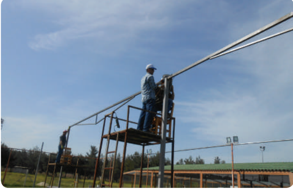
Kır Düğün Salonu Oturma Parkı Üst Kapatma İçin Profil Montaj İşİ
