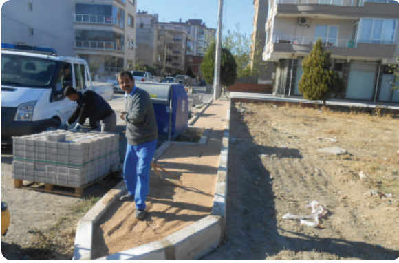
Irmak Mahallesi 97 Sk. Kaldırım Çalışması
