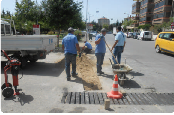
Abdullah Aydın Parkı İçi Taş Tamiri ve İzgara Yapım İşİ
