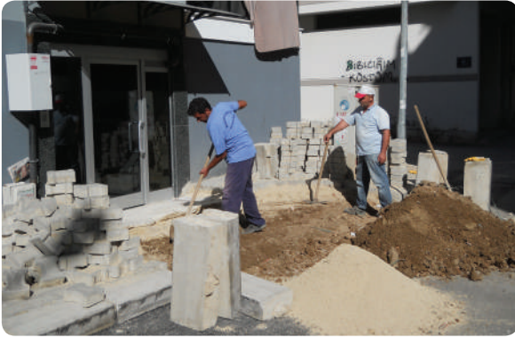
Yeşil Mahalle 52 Sk. Kaldırım Tamiri İşi
