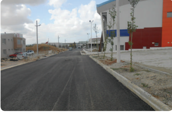
Sarnıç Kapalı Spor Salonu Asfalt Çalışması
