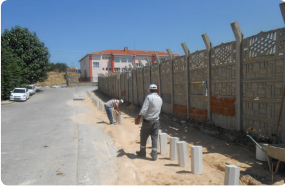
Fatih Mah. 1181 Sk. Kaldırım Çalışması
