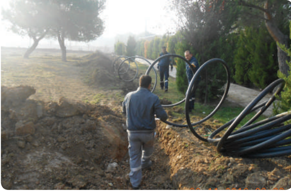
Sarnıç Kır Düğün Salonu Sulama Tesisat İşi
