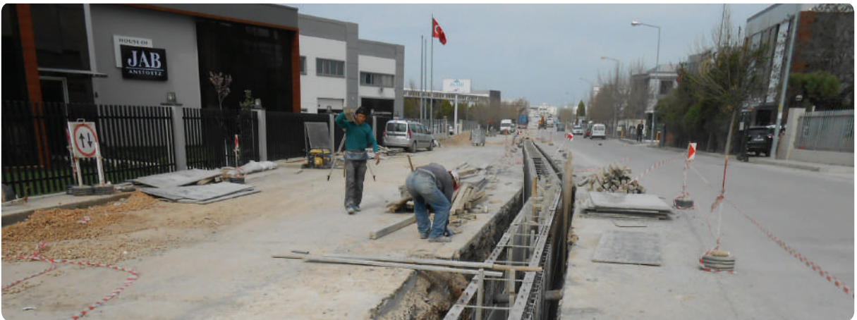
Sarıç Yağmur Suyu Kanalı Çalışması
