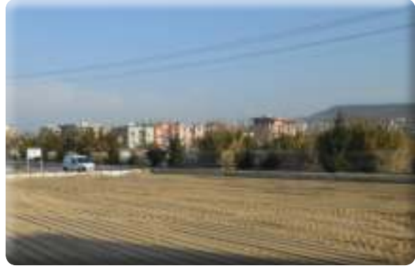
9 Eylül Mahallesi Kahramanlar Caddesi otopark yapım işi
