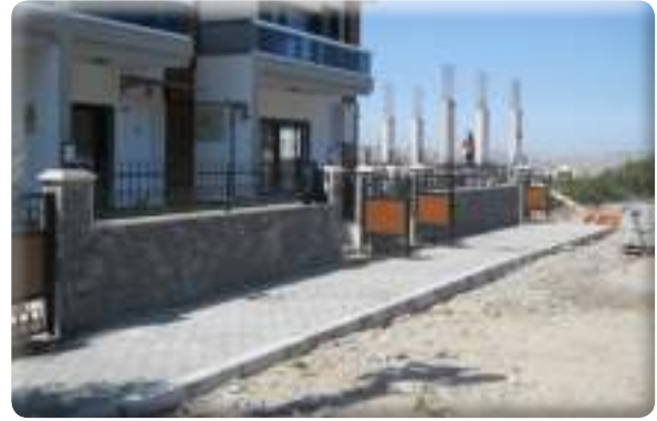
Beyazevler Mahallesi 548 Sokak kaldırım yapımı
