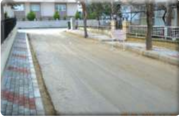
Yeşil mahalle 59/1 Sokak kaldırım yapımı işi
