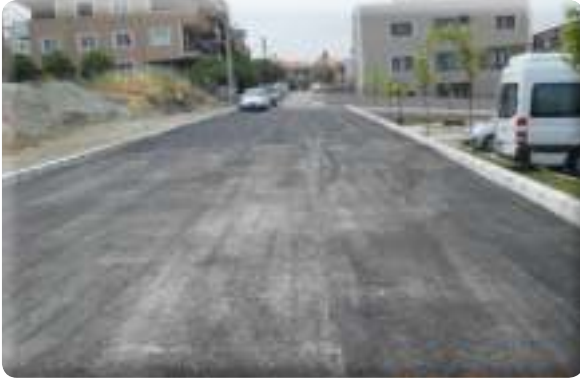
Beyazevler Mahallesi 545 Sokak kaldırım ve asfalt yapılması
