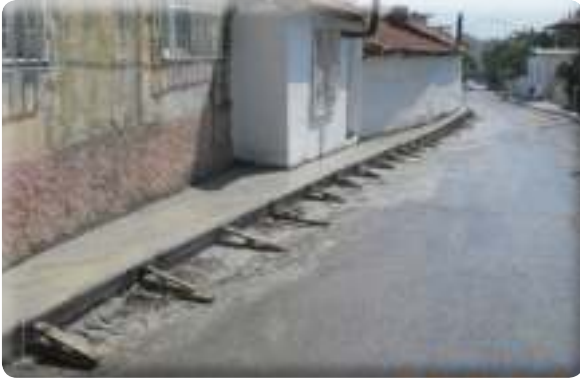
Yeşil Mahalle 40 Sokak kaldırım çalışması
