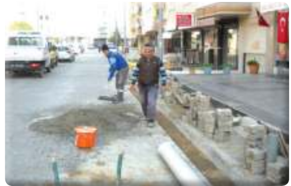
Atıfbey Mahallesi 6/4 Sokak yağmur suyu kanalı yapımı
