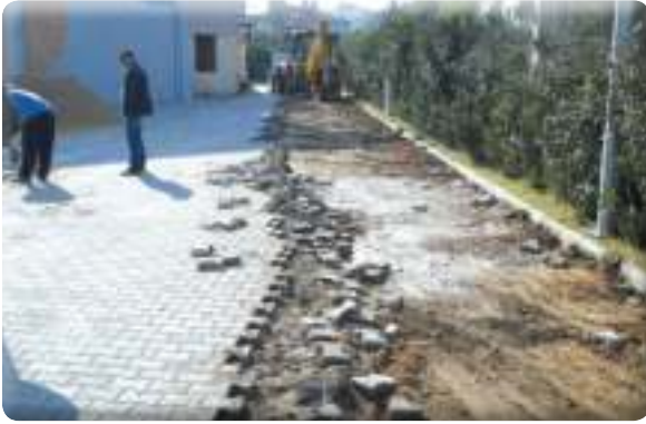
Atıfbey Mahallesi Esbaş spor salonu taş tamirâtı
