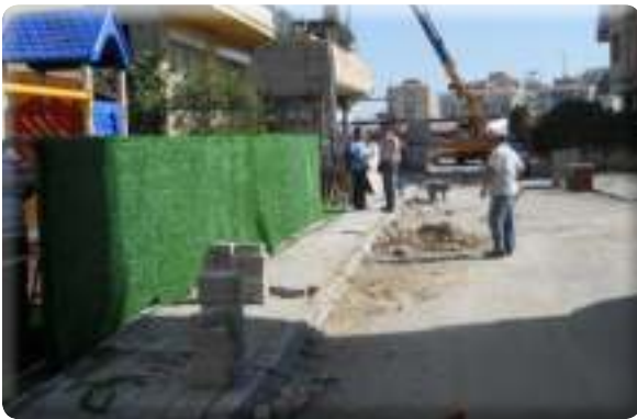
Atıfbey Mahallesi 67 Sokak kaldırım taş tamirâtı
