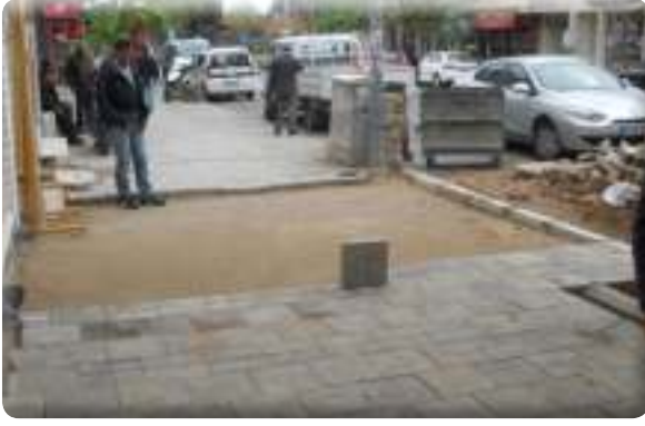
9 Eylül Mahallesi Önder Caddesi kaldırım çalışması
