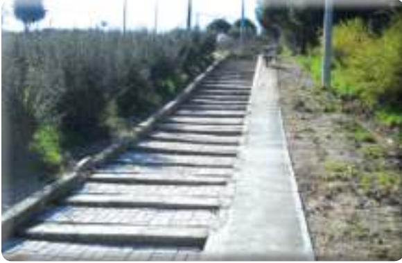
Sevgi Mahallesi Nevvar Salih İşgören Caddesi merdiven tamiri ve rampa yapımı
