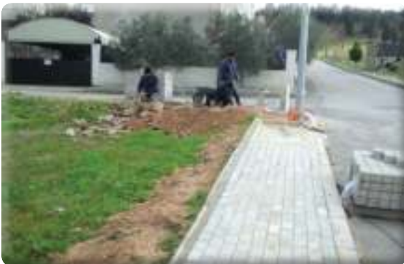
Beyazevler Mahallesi 527 Sokak taş tamiri yapılması işi
