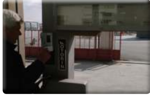
Belediyenin hizmet araçlarına akaryakıt otomasyon sistemi ile verilmektedir. Her araca "araç yakıt kartı" ve her şoföre; "şoför yakıt kartı" verilmiştir. Araçlar Makine İkmal Akaryakıt istasyonuna yakıt almaya geldiğinde pompa üzerinde mevcut bulunan "otomasyon sistemine" aracın "araç yakıt kartı" ve "şoför yakıt kartı"tanıtılıyor.
