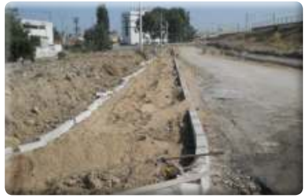
Binbaşı Reşatbey Mahallesi 370/1 Sokak kaldırım çalışması
