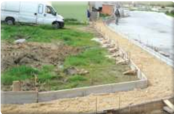
Binbaşışatbey Mahallesi 397/3 Sokak kaldırım yapımı
