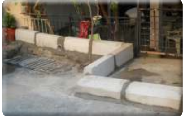
9 Eylül Mahallesi. 313 sok. yağmur kanal çalışması
