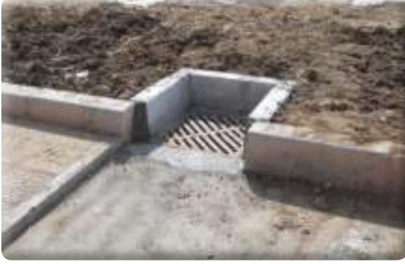
Gazi Umurbey Anaokulu yağmur suyu kanal yapımı
