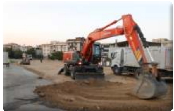
Gazi Mahallesi Metin Henkoğlu Caddesi yol birleşim çalışması
