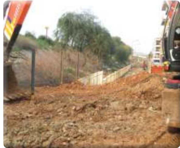
9 Eylül Mahallesi 351 Sokak dolgu çalışması
