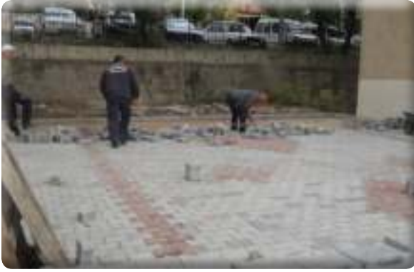
Aktepe Mahallesi 114 Sokak Bordür ve parke döşeme işi
