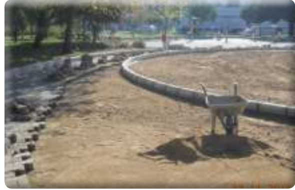
Gazi Mahallesi Ümit Akdağ parkı bordür yapımı işi
