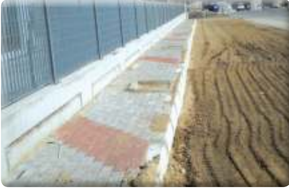
9 Eylül Mahallesi 695 ve 694 Sokaklar kaldırım yapımı işi
