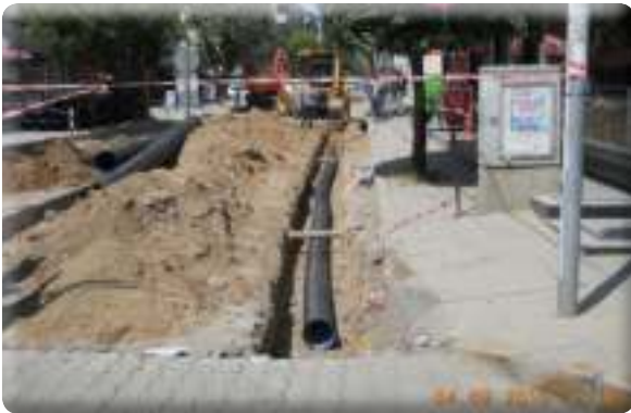
Gazi Mahallesi Yarbay Refik Cesur Caddesi ile Önder Caddesi yağmur suyu bağlantısı, ızgara döşenmesi işi
