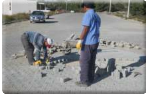
Beyazevler Mahallesi 556 Sokak yol taş taminatları
