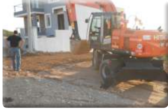
Beyazevler Mahallesi 563 Sokak yol çalışması
