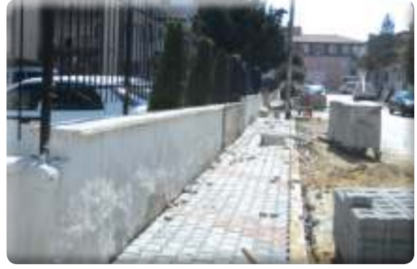
Irmak Mahallesi 97 Sokak ve 99/4 Sokak kaldırım yapımı işi
