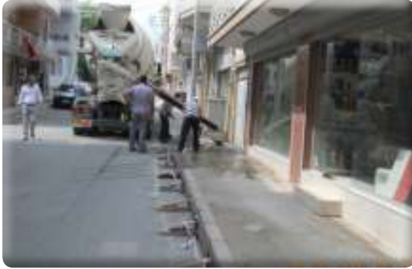
Gazi Mahallesi Millet Caddesi kaldırım yapımı işi
