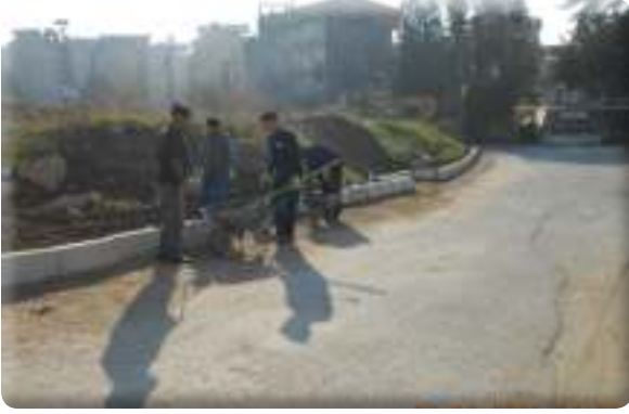
Emrez Mahallesi bordür çalışması
