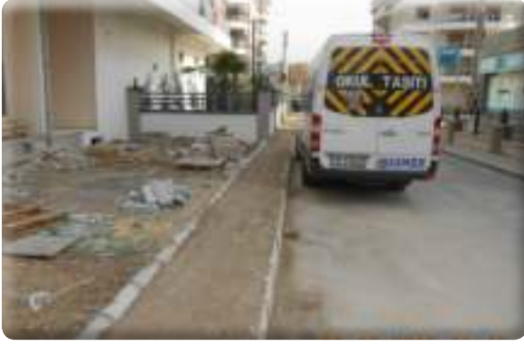
Irmak Mahallesi 38/6 sokak. kaldırım çalışması
