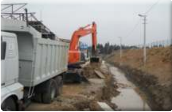
9 Eylül Mahallesi 695 sokak kanal çalışması
