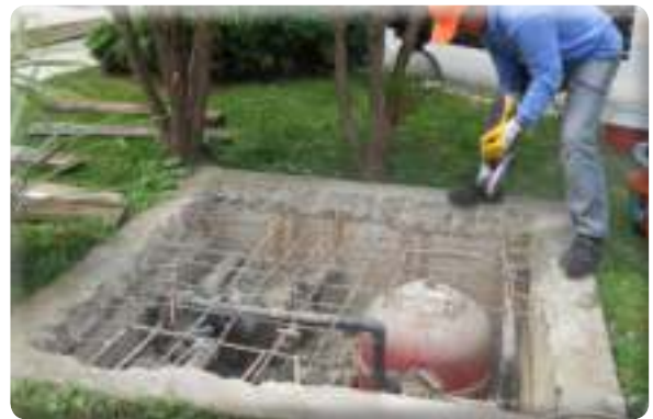
Atıfbey Mahallesi Sevgi yolu 3. etap havuz makine dairesi yenileme
