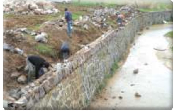
Irmak Mahallesi Irmak Deresi duvar ve korkuluk yapımı
