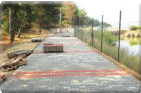
Sarıncı gölet yolu taş döşenmesi yapılıması işi
