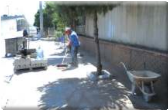
9 Eylül Mahallesi Kıpa köprüsü yan kaldırım yapım işi
