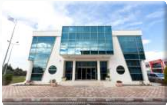
Gazimir Belediyesi Sarnıç Hizmet Binası
