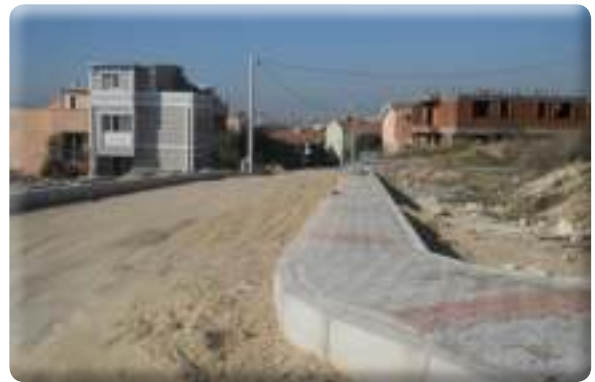
Beyazevler Mahallesi 548/ 2 Sokak kaldırım ve yol çalışması
