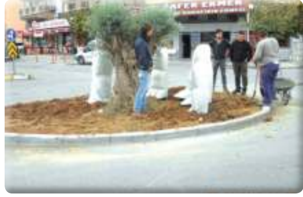
Atıfbey Mahallesi Türkan Saylan kavşağı zeytin ağacı ve heykel dikim çalışması
