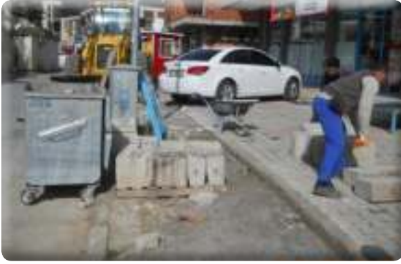
Irmak Mahallesi 31 Sokak ve 35 sokaklar kaldırım çalışması
