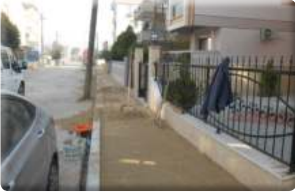
Gazi Mahallesi 27/ 1 Sokak kaldırım çalışması
