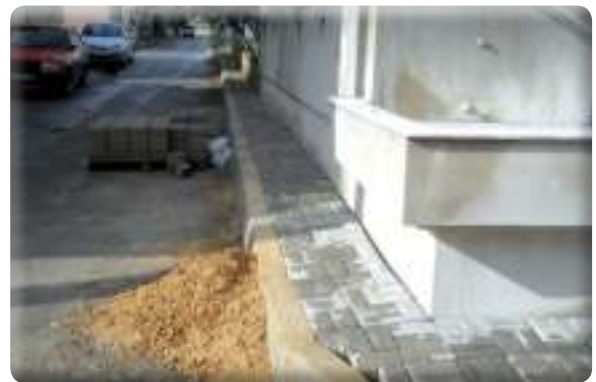
9 Eylül Mahallesi 319 Sokak kaldırım yapımı işi
