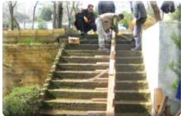
Sevgi Mahallesi 80/10 Sokak merdivenlere rampa yapımı
