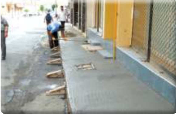
Gazi Mahallesi Millet Caddesi kaldırım yapımı işi
