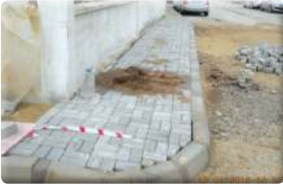
Irmak Mahallesi 38/23 Sokak açılması ve kaldırım yapımı
