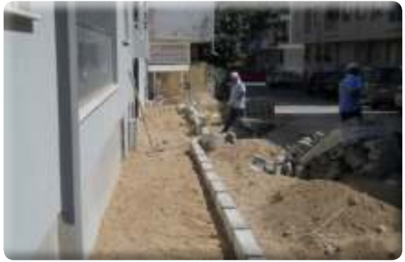
Irmak Mahallesi 39 -34 sokak kaldırım çalışması
