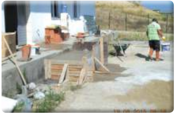
Sevgi Mahallesi veterinerlik binası muhtelif iş çalışmaları
