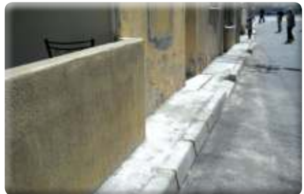
Aktepe Mahallesi 143 Sokak kaldırım yapımı
