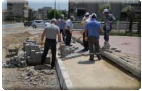
Irmak Mahallesi 38 Sokak drenaj ve kaldırım yapımı
