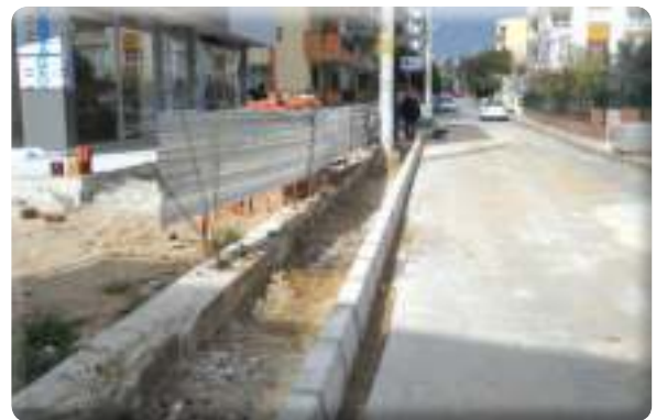
Atıfbey Mahallesi 8 Sokak kaldırım yapımı işi
