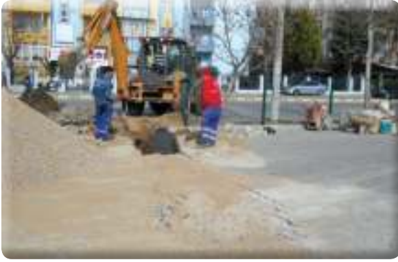
Atıfbey Mahallesi Esbaş Kapalı Spor Salonu kanal değişimi
