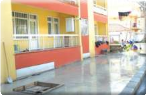
9 Eylül Mahallesi 303 Sokak kaldırım yapımı işi
