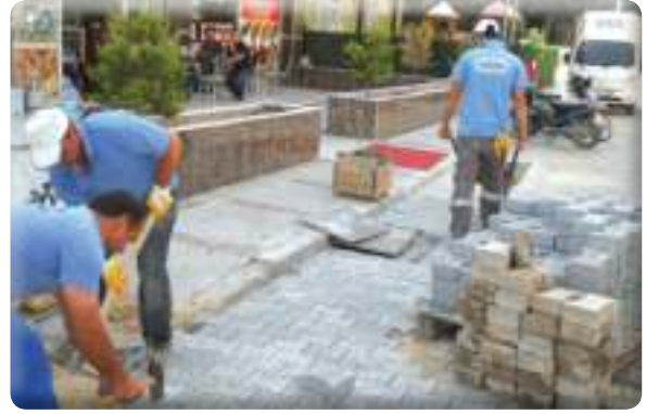
Atıfbey Mahallesi 11/3 Sokak ızgara yapımı
