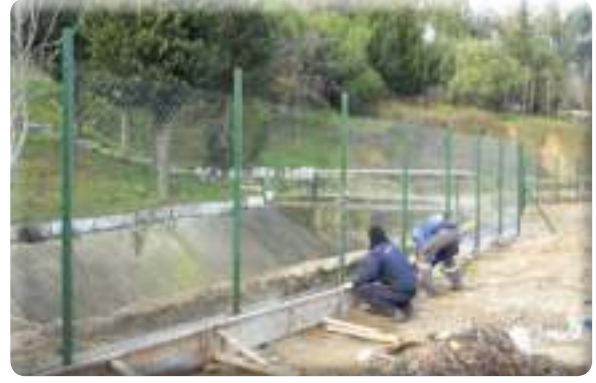
Sevgi Mahallesi eski şantiye hayvan barnağı tel çit ve beton işleri
