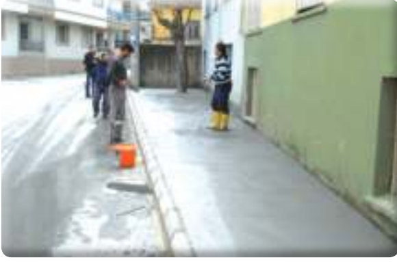
Gazi Mahallesi Hasan Güven Caddesi kaldırım yapımı
