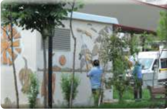
Atıfbey Mahallesi Nazif Uysal Parkı trafo boya işi
