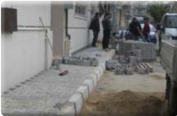
Gazi Mahallesi 22 Sokak kaldırım çalışması
