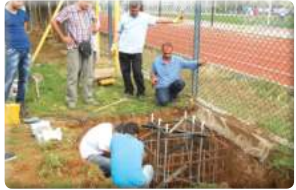
Atıfbey Mahallesi Esbaş Futbol Sahası skorboard ankrâj betonu
