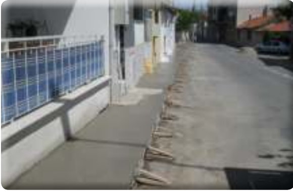
Yeşil Mahalle 40 Sokak kaldırım çalışması 1.etap
