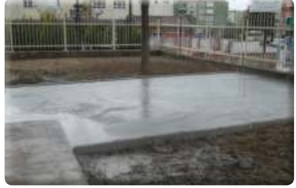
Gaziemir Anaokulu beton dökümü işi
