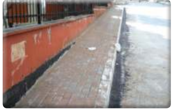
Yeşil Mahalle 59/1 Sokak 58 Sokak kaldırım yapımı
