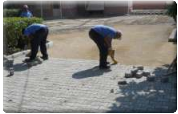
Yeşil Mahallesi Toplum Sağlığı Merkezi taş döşeme işi
