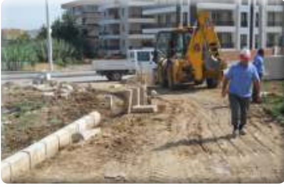
Irmak Mahallesi dere kanal yanı park bordur çalışması
