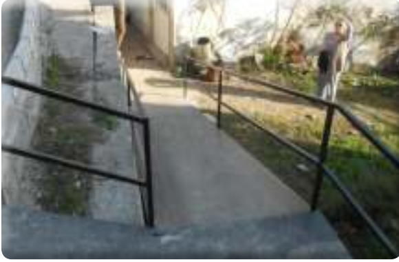
Aktepe Mahallesi 187 Sokak engelli rampası yapım işi
