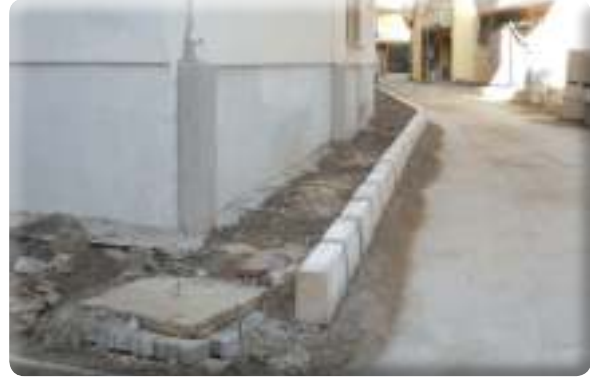
Gazi Mahallesi 18 Sokak kaldırım yapımı işi
