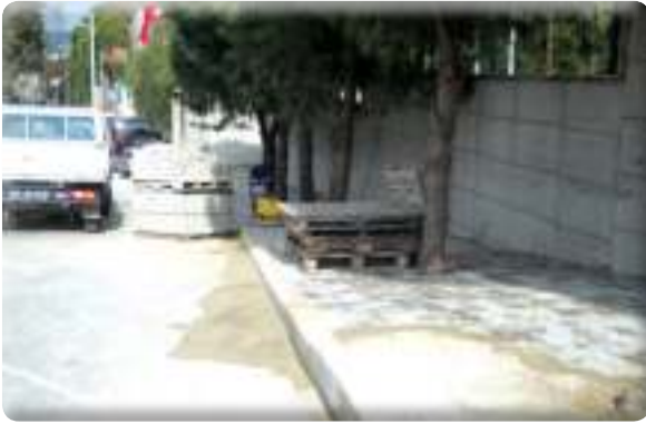
9 Eylül Mahallesi 699 Sokak kaldırım yapımı işi
