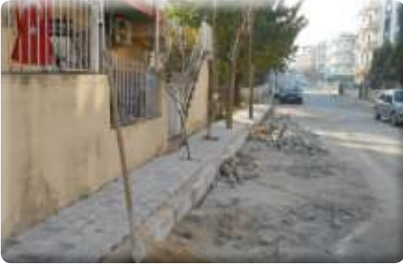
Irmak Mahallesi 97 Sokak. kaldırım çalışması
