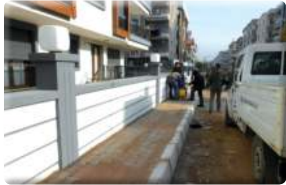
Atıfbey Mahallesi Etiler Caddesi kaldırım çalışması
