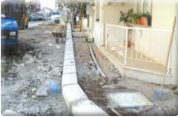
Yeşil Mahalle 53 Sokak kaldırım yapılması
