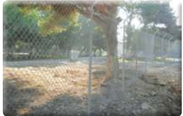
Sarıuç Piknik Alanı çit yapım işi
