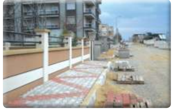
9 Eylül Mahallesi 351 Sokak kaldırım yapımı
