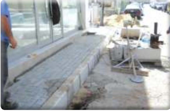
9 Eylül Mahallesi Zambak Sokak kaldırım yapımı
