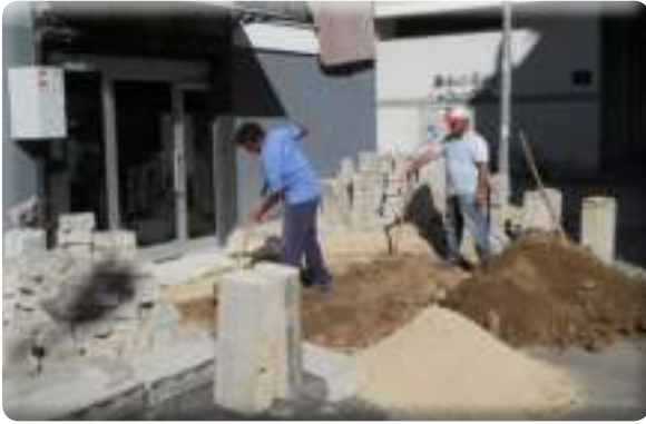
Yeşil Mahalle 52 Sokak kaldırım tamiri işi
