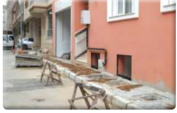
Yeşil Mahalle Hasan Güven Caddesi kaldırım yapımı
