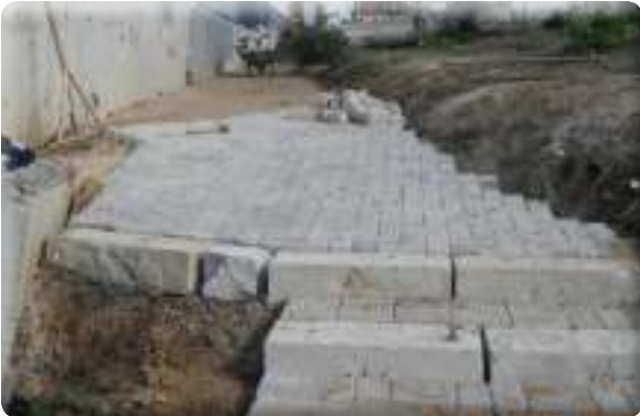
Aktepe Mahallesi 108 Sokak merdiven çalışması
