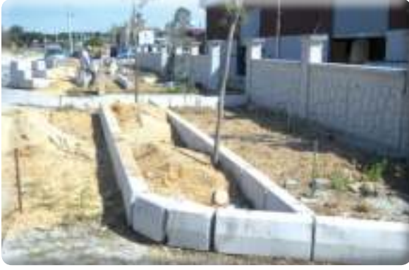
9 Eylül Mahallesi 695 Sokak kaldırım yapımı
