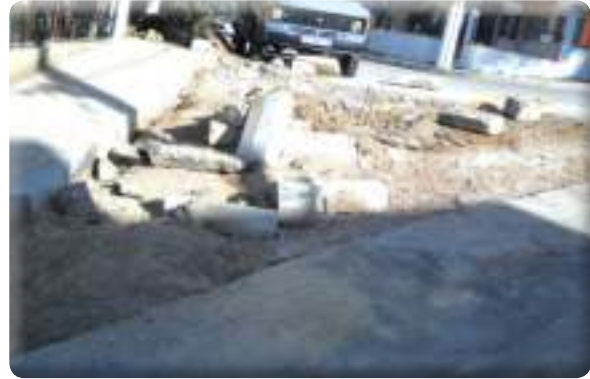
Beyazevler Mahallesi 547 Sokak kaldırım yapımı
