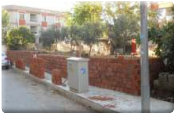
Yeşil Mahalle 55 Sokak kaldırım ve duvar yapım işi
