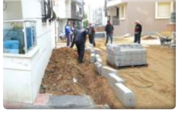
Gazi Mahallesi 22/1 Sokak açılması kaldırım yapımı
