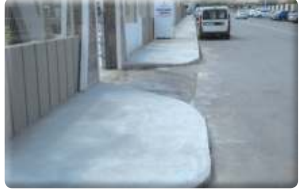
Irmak Mahallesi 700 Sokak Eroğlu Cami kaldırım yapımı
