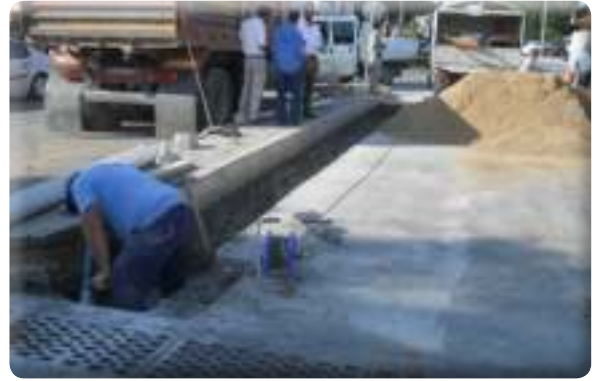
9 Eylül Mahallesi pazar yeri kanal yapım işi
