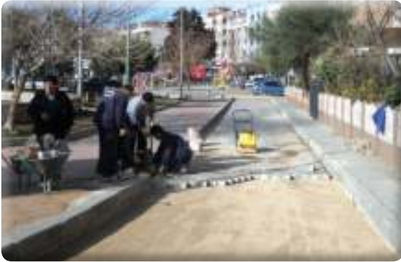
Atıfbey Mahallesi Gökhan Boru Parkı taş tamirati
