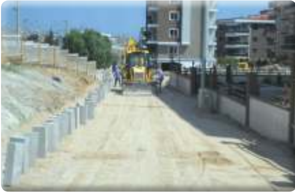
Beyazevler Mahallesi 351 Sokak kaldırım ve yol çalışması
