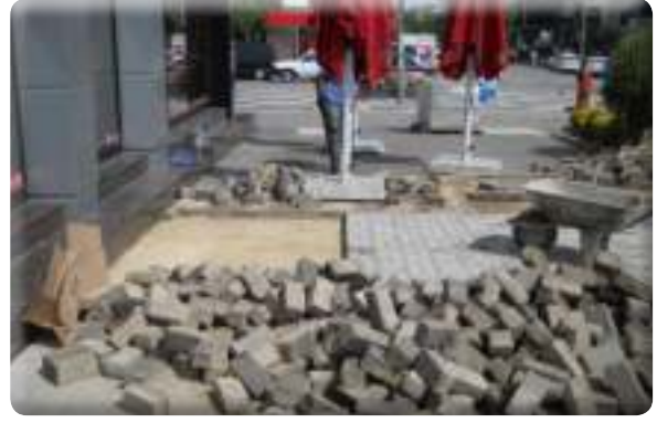
Atıfbey Mahallesi Kemal Reis Caddesi kaldırım tamirâtı
