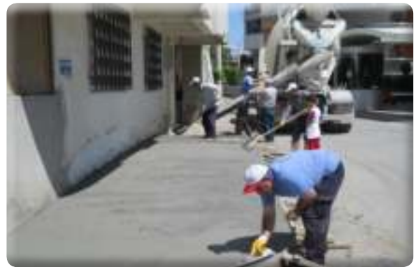
Irmak Mahallesi 38/11 ve 38/12 Sokak kaldırım yapımı
