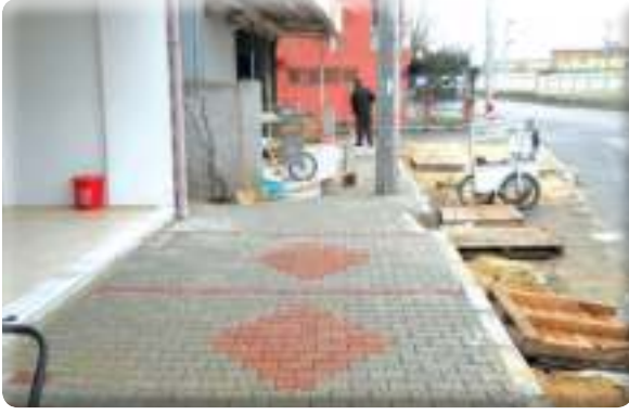
9 Eylül Mahallesi 351 Sokak kaldırım yapımı işi
