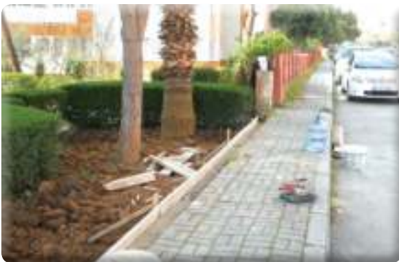
Atıfbey Mahallesi 56 Sokak beton işi
