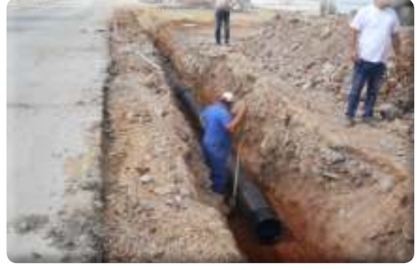
Sarnıç 1191 Sokak yağmur suyu hattı çalışması
