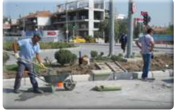
Atıfbey Mahallesi Akçay Caddesi Tansaş arkası kavşak tamaratı işi
