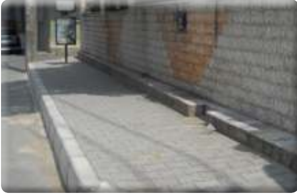
Emrez Mahallesi Emrez cami önu kaldırım çalışması
