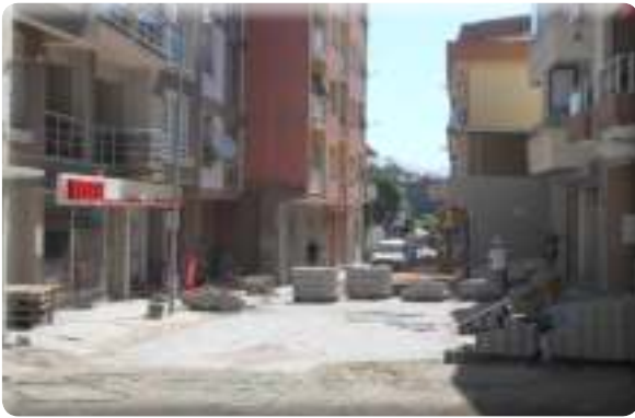
Irmak Mahallesi Metin Henkoğlu caddesi taş yenileme parke döşeme işi
